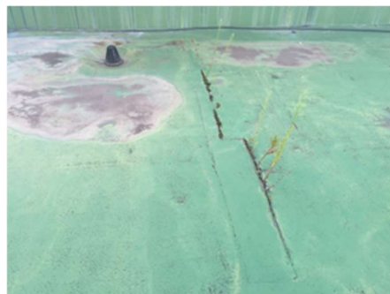
本庁舎屋上防水の状況
