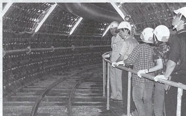
▲工事中のトンネルの様子
