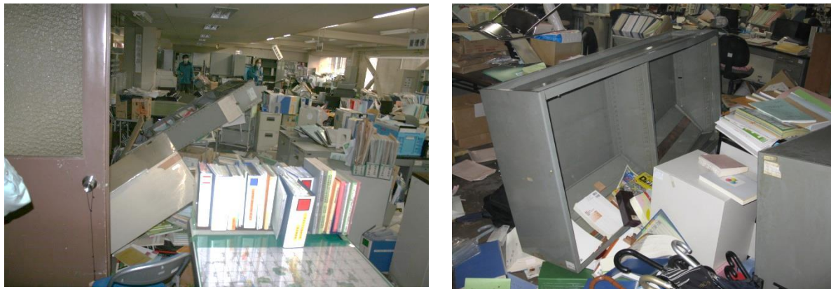
画像：東日本大震災直後の什器が転倒した庁舎内の様子
