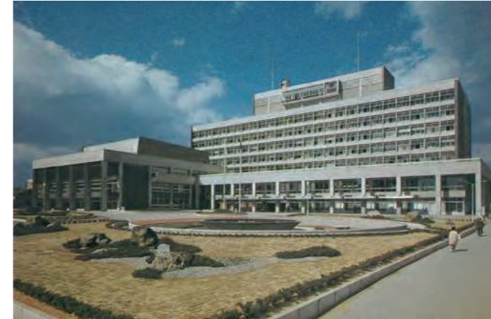
1965年（昭和40年）SRC造 コンクリート打放し（一部タイル張り） 構造体のコンクリートをそのままあらわして用いた端正な外観。
