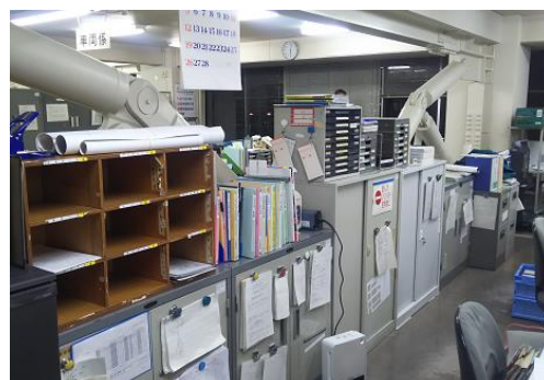
制震ブレースにより 分断された事務室
