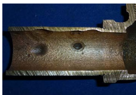
空調設備配管内部の状況
