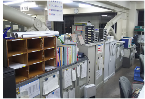
制震ブレースにより分断された事務室
