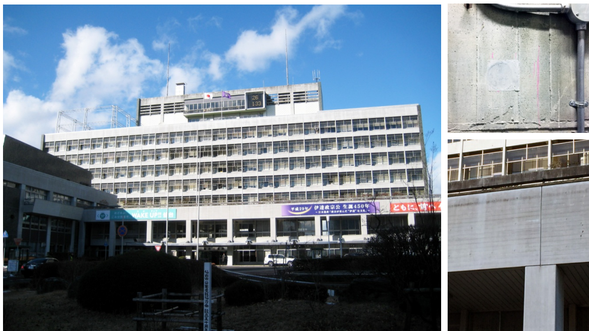
【左】本庁舎外観 【右上】中性化調査のサンプル採取跡 【右下】外壁のコンクリート打放し部分の例
