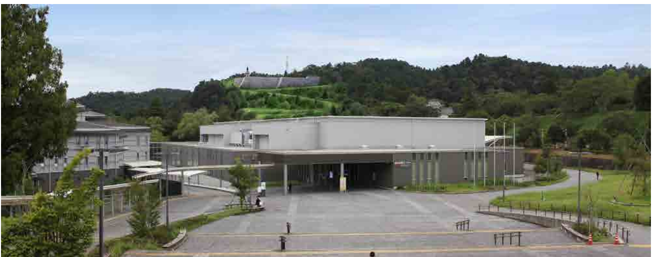
③ 国際センター駅からみた仙台城跡の景観
