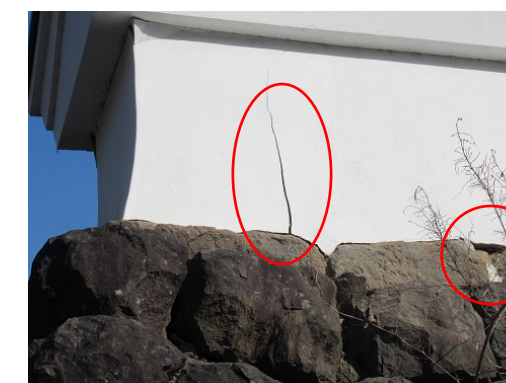
④ 大手門北側土塀(南から)
