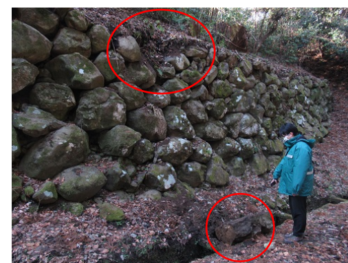
② 沢門下石垣(南東から)
