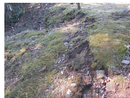
⑤ 大手門脇櫓付近法面(北から)
