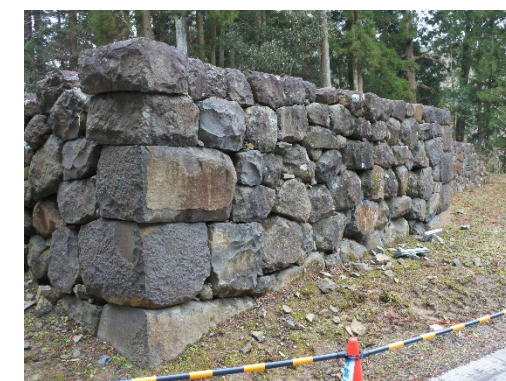
①-2 中門南側石垣(北東から)
