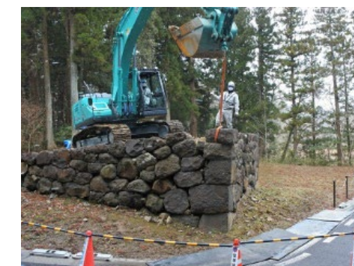
①-3 中門南側石垣応急措置(東から)
