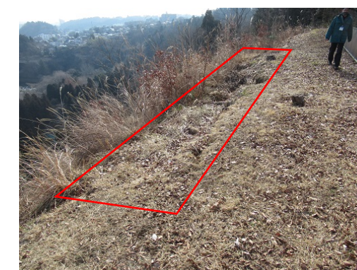
⑥ 本丸異櫓跡付近崖面(北から)
