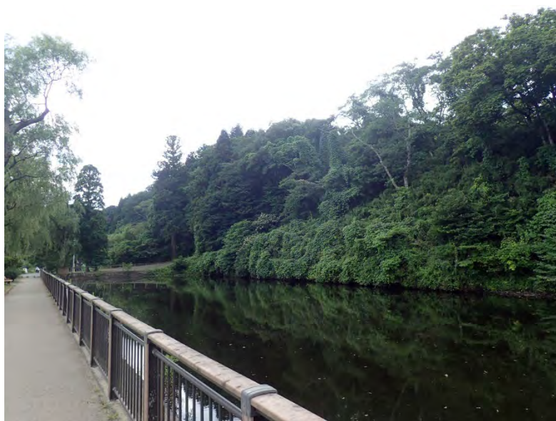
図 5-5 除草対象となる土塁に生育する下層植生の状況
