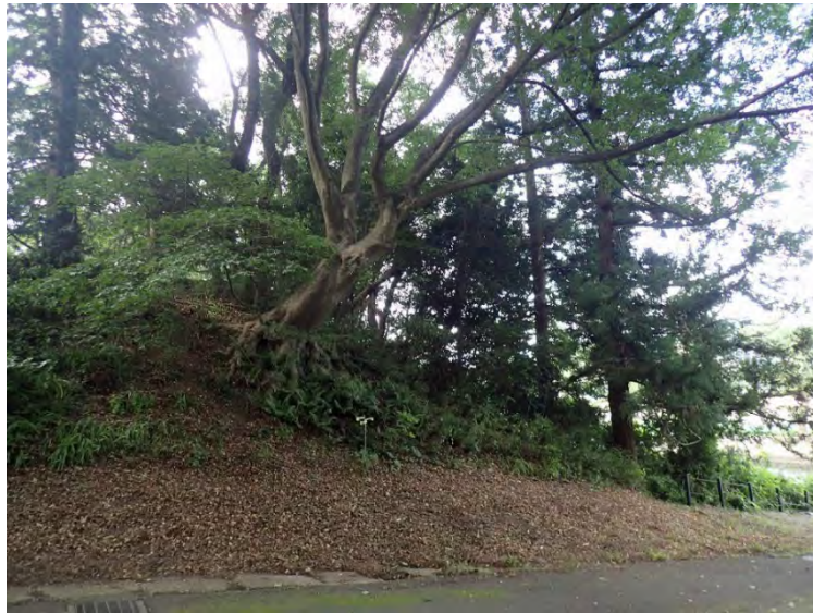
図 5-10 東側登城路沿いの土塁に生育するイタヤカエデ (根返りを起こし倒木の危険があるため伐採)
