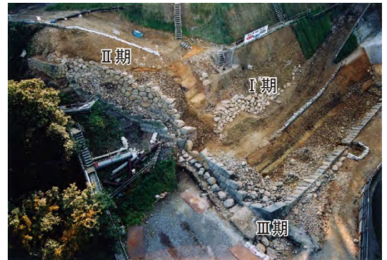
図 4-3 本丸北壁石垣で確認した3時期の石垣
