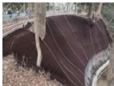
図 4-136 本丸東側崖地補強工事
