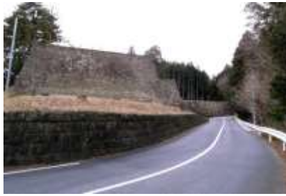
図 4-5 本丸北西石垣② (平成 23 年に被災し復旧)
