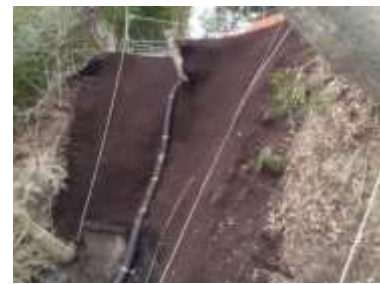
図 4-138 本丸東側崖地補強工事
