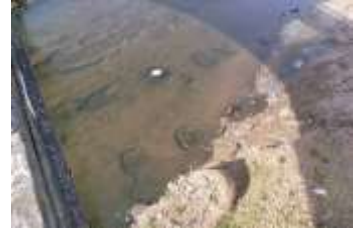
図 4-142 河床の穴② （大橋関連遺構か）
