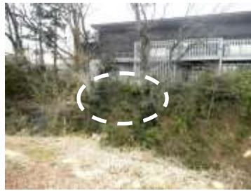
図 4-99 筋違橋付近の石垣⑦-1
