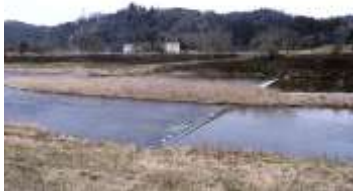
図 4-143 東から見た護岸石垣
