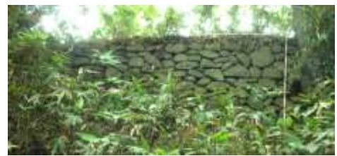
図 4-100 筋違橋付近の石垣⑦-2
