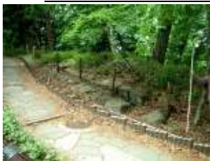
図4-41 石組側溝1①
