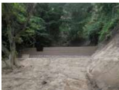
図 4-139 崖地下部の崩落土砂流失防止のための土留
