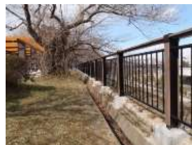
図4-116 東側土手のフェンス・側溝
