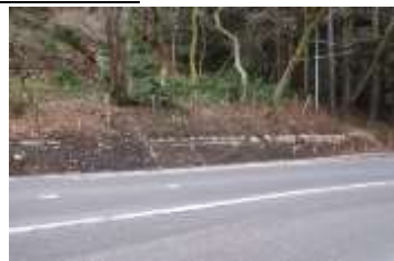
図4-42 石組側溝2②
