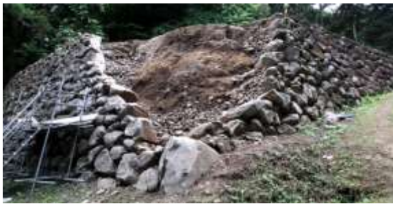
図 3-37 清水門跡 (H23 地震修復) 解体状況
