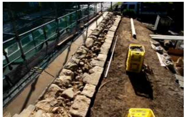
図 4-47 大手門北側土塼の地覆石
