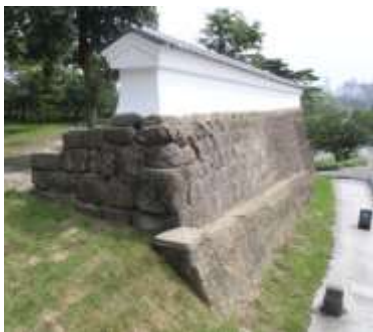
図 4-48 大手門北側土塼 H23 地震修復後
