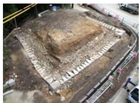
図 3-34 中門跡(H23地震修復) 解体状況
