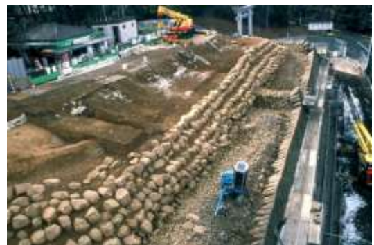
図 3-13 本丸北壁石垣 栗石と盛土の境界にある階段状石列
