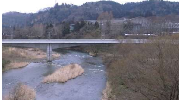
図 5-13 中の瀬橋からの遠景 (平成 27 年 3 月撮影)
