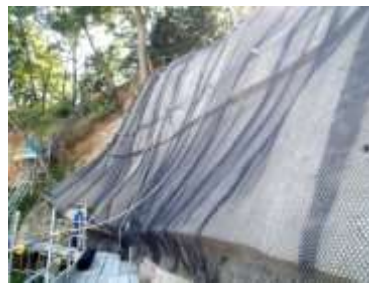
図 4-137 本丸東側崖地補強工事
