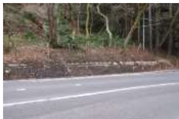
図4-42 石組側溝2②
