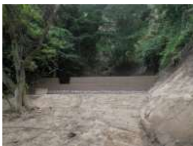
図 4-139 崖地下部の崩落土砂流失防止のための土留
