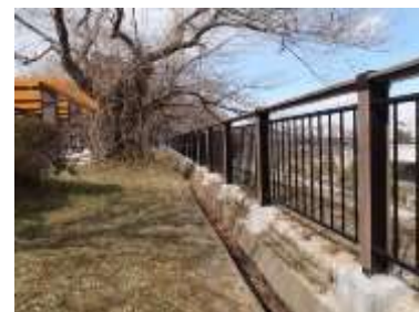
図 4-116 東側土手のフェンス・側溝
