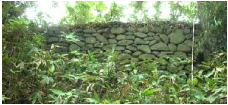
図 4-100 筋違橋付近の石垣⑦
