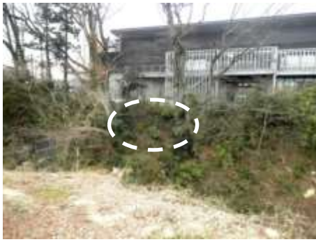
図 4-99 筋違橋付近の石垣⑦
