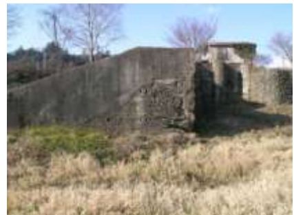
図 4-150 大正 9・10（1920・21） に建設された水力発電のための 取水口
