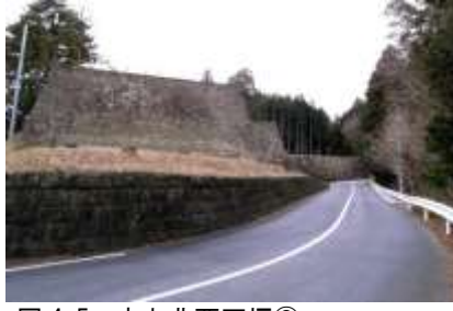
図 4-5 本丸北西石垣② (平成 23 年に被災し復旧)
