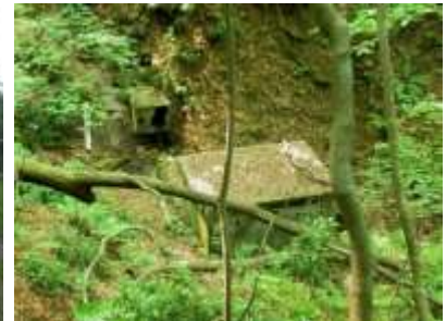
図 4-39 御清水付近のコンクリート 造施設
