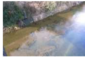
図 4-141 河床の穴と、切石積み石垣①
