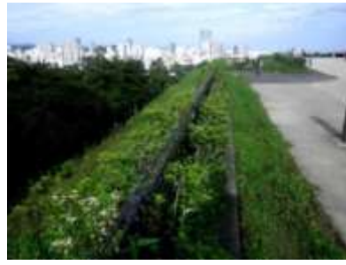
図 4-29 本丸北壁石垣天端のフェンス（フェンス両脇に植栽）
