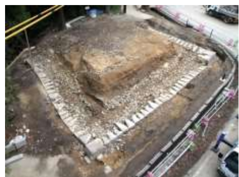
図 3-34 中門跡（H23地震修復） 解体状況
