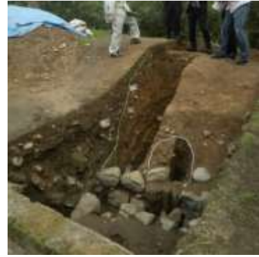
図 3-30 三の丸（東丸）土塁の調査状況
