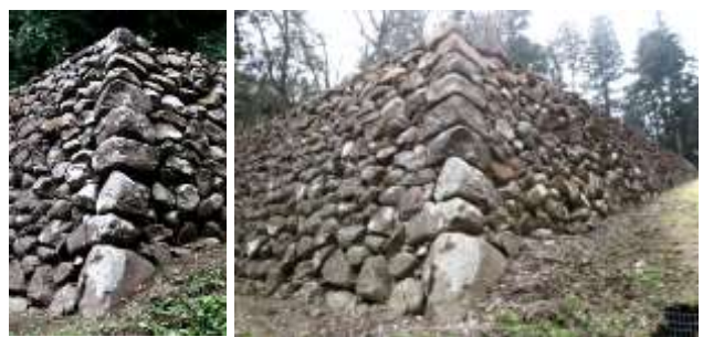
図 3-38 清水門跡 (H23 地震修復) 左：修復前 右：修復後
