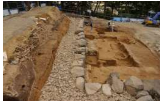
図 3-32 中門跡（H15地震修復） 解体状況
