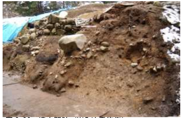
図 3-36 清水門跡 (H15 地震修復) 石垣基部と礎石
