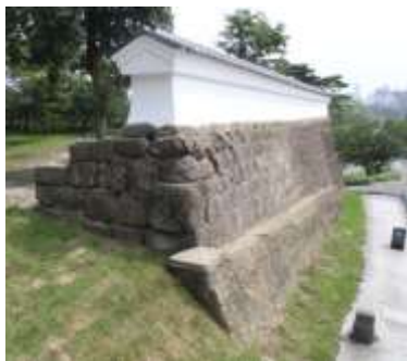
図 4-48 大手門北側土塀 H23 地震修復後
