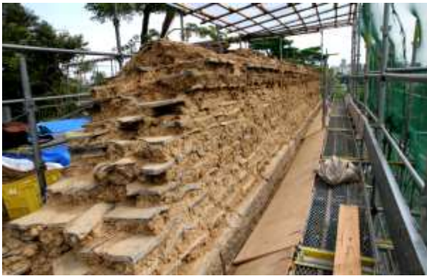
図 4-46 大手門北側土塀の躯体部 土と瓦を交互に積む
