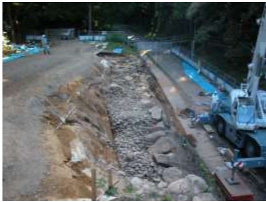
図 3-35 清水門跡 (H15 地震修復) 解体状況
