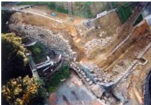
図 3-12 本丸北壁石垣 北東部で築城期石垣とその後の2回の修復を確認した
