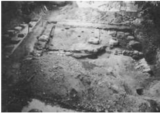
図 3-29 巽門跡の調査状況
