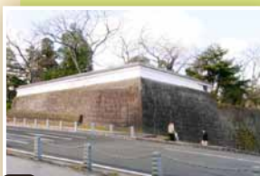
2 大手門北側土塀(現存建築物)
