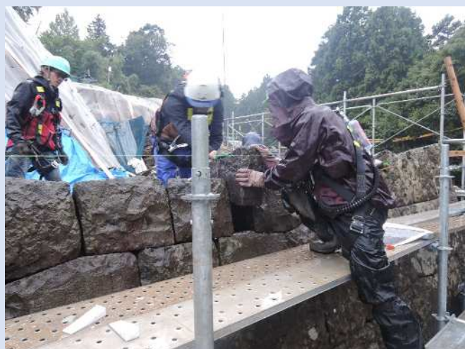
石積み作業の様子
