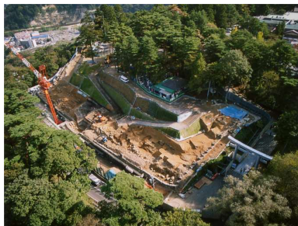
本丸北壁石垣（工事中の様子）
