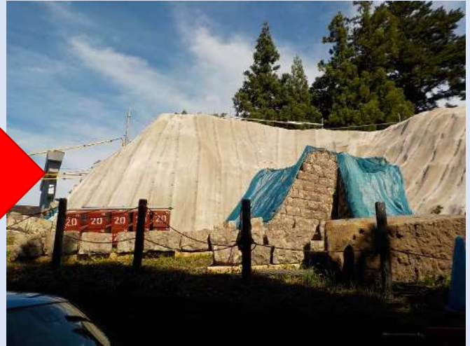
解体が完了した石垣(令和6年6月撮影)
