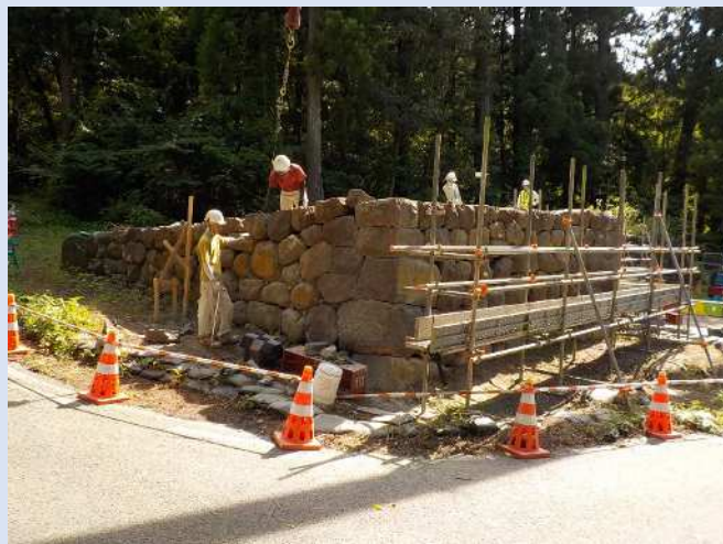
石積み作業の様子
