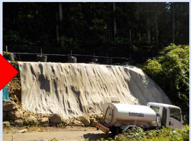
解体が完了した石垣(令和6年6月撮影)
