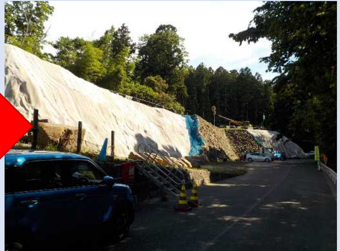
解体が完了した石垣(令和6年6月撮影)
