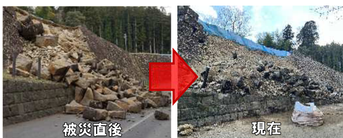
石垣解体作業の様子
