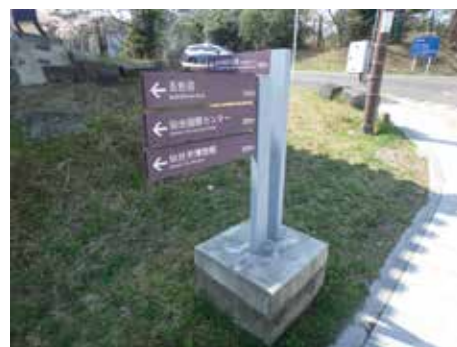
図 7-24 遺構保護に配慮した サイン (大手門脇櫓前)
