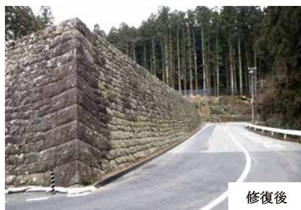
図 2-7 東日本大震災による本丸北西石垣の被災と修復状況
