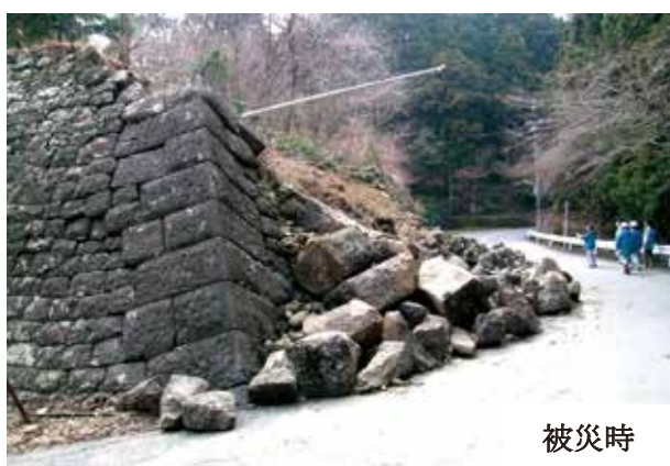
図 2-7 東日本大震災による本丸北西石垣の被災と修復状況
