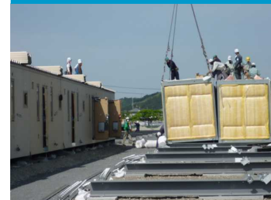
仮設場所での据え付け作業
