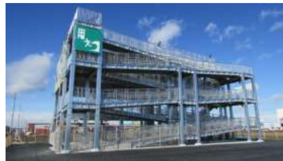
H27.2に竣工した津波避難タワー
