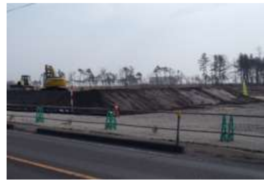
かさ上げ道路の盛土状況(井土工区)
