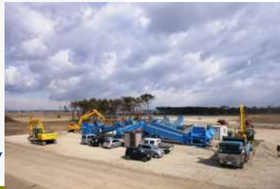
津波堆積土砂の改良状況
