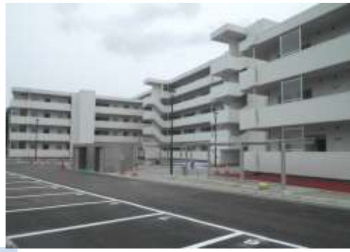
霊屋下第二(H27.9月完成)
