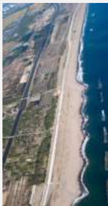
海岸防潮堤 (H27.9撮影)
