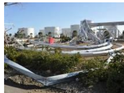
ガス局港工場
