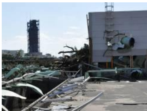
南蒲生浄化センター
