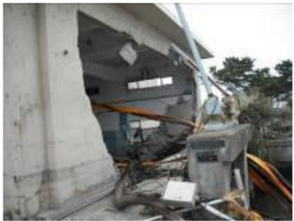
高砂南部排水機場
