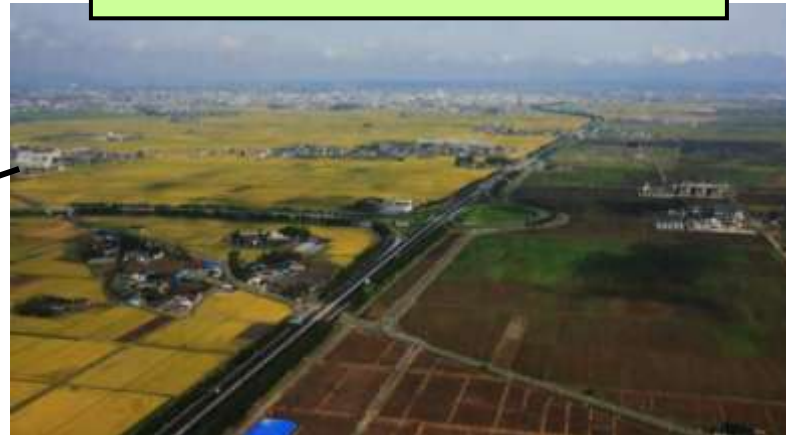
堤防代わりとなった仙台東部道路
