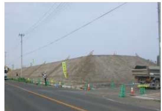
かさ上げ道路の盛土状況(井土工区)
