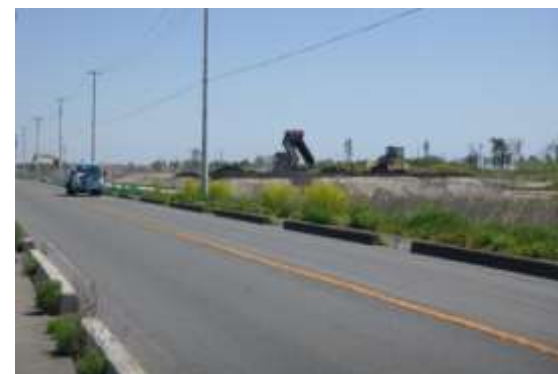
かさ上げ道路の盛土状況(井土工区)
