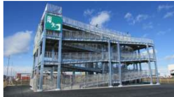
H27.2に竣工した津波避難タワー
