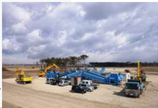
津波堆積土砂の改良状況
