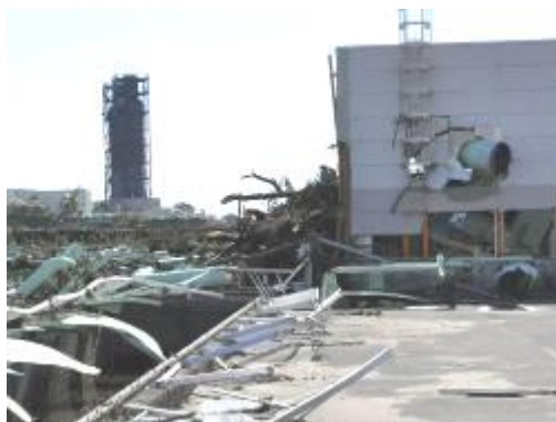
南蒲生浄化センター
