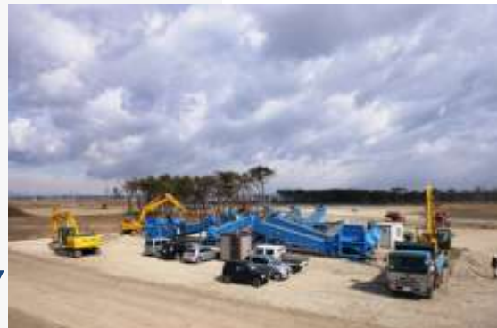
津波堆積土砂の改良状況
