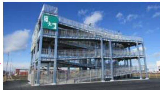
H27.2に竣工した津波避難タワー
