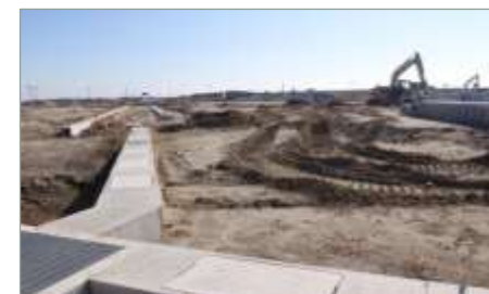
インフラ整備が進む六郷地区 (H26.11撮影)
