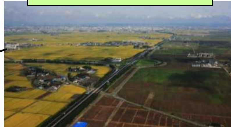
堤防代わりとなった仙台東部道路
