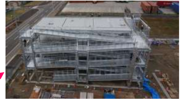
建設中の津波避難タワー(H26.12現在)
