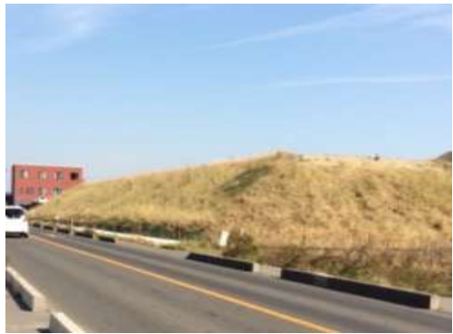
かさ上げ道路の盛土状況(荒浜工区)
