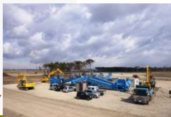
津波堆積土砂の改良状況
