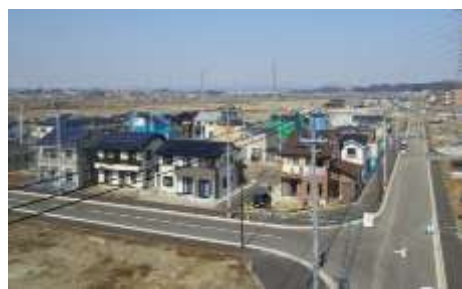
田子西地区で進む住宅建設の様子(H26.3撮影)
