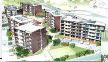
田子西復興公営住宅
