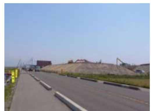
かさ上げ道路の盛土状況 (H26.6.17現在)
