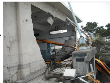
高砂南部排水機場
