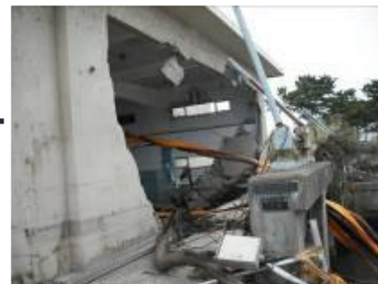
高砂南部排水機場
