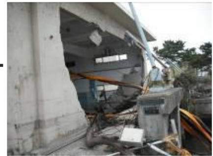
高砂南部排水機場
