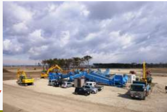
津波堆積土砂の改良状況
