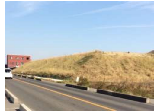
かさ上げ道路の盛土状況(荒浜工区)
