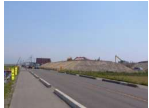
かさ上げ道路の盛土状況 (H26.6.17現在)
