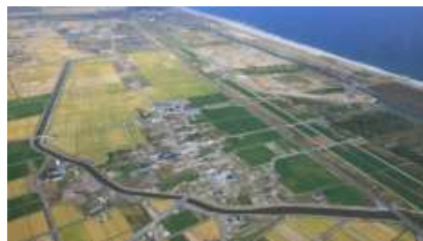
←ほ場整備により 大区画化された農地 (H26.9月)
