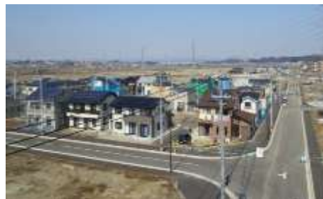
田子西地区で進む住宅建設の様子(H26.3撮影)
