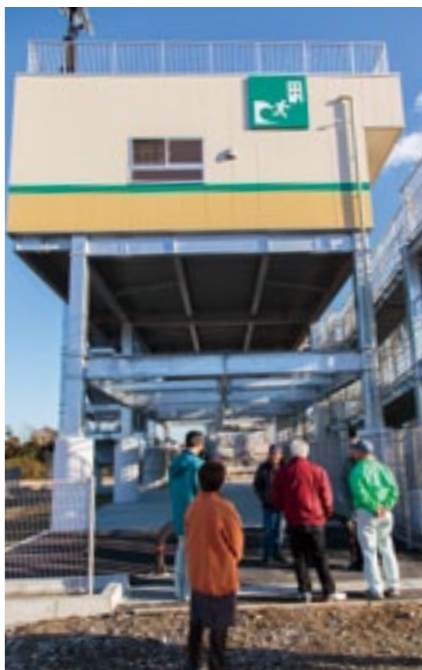
津波避難タワーは想定される浸水深から十分な高さとなるおおむね6m以上に避難が可能で、雨風や寒さをしのぐ屋内空間も設けている。
