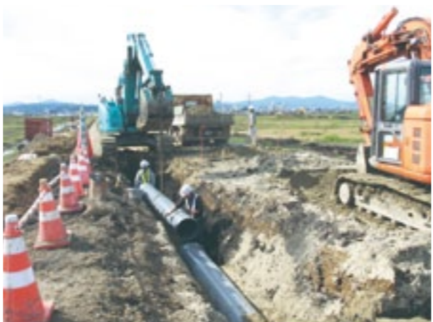
用水路整備の様子。地下に総延長153kmにも及ぶバイブラインが埋め込まれ、水管理の省力化が図られている。
