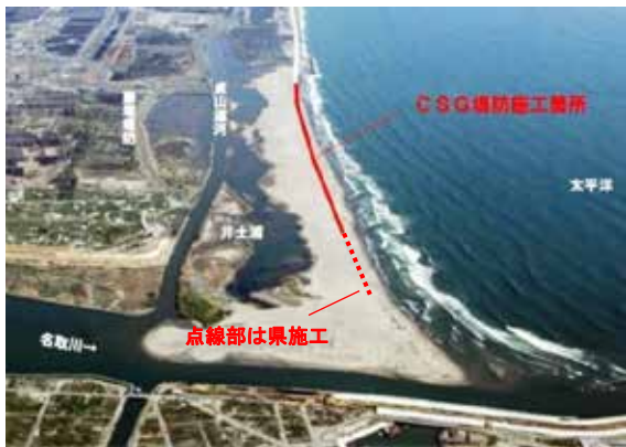
図表 12-2-6 CSG堤防の施工箇所
