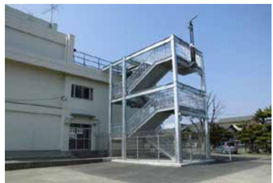
写真 津波避難屋外階段(高砂中学校)
