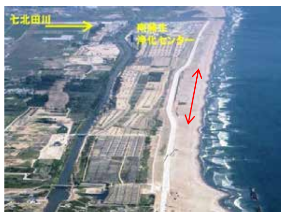
図表 12-2-4 新浜地区の海岸堤防
