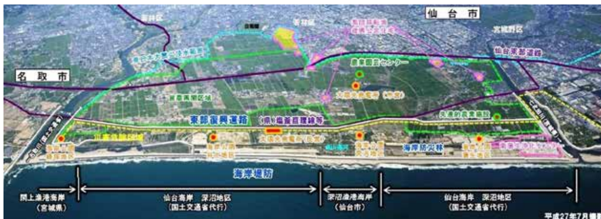
図表 12-2-3 本市の海岸堤防復旧状況
