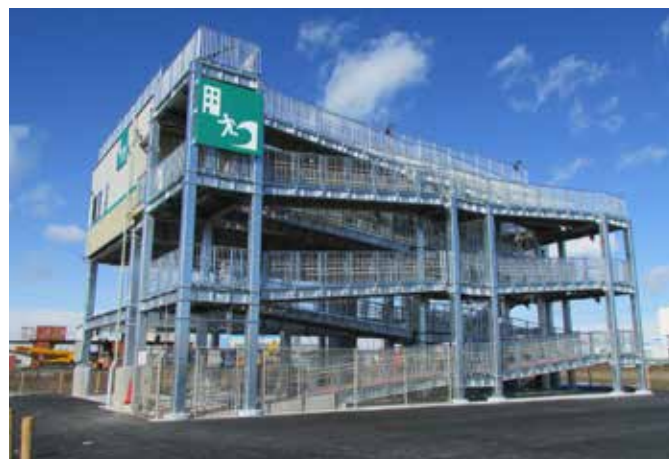
中野五丁目津波避難タワー（平成 27 年 2 月）
