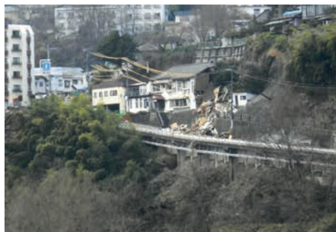
太白区向山で発生した家屋倒壊被害
