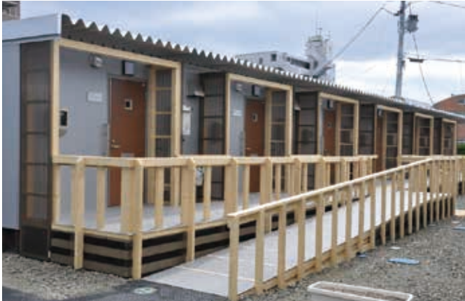
荒井土地区画整理事業小学校用地仮設住宅（平成 23 年 5 月）
