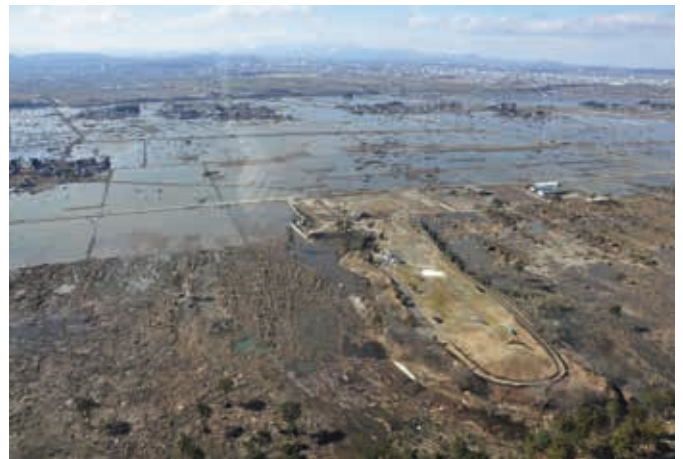
震災後の海岸公園冒険広場
