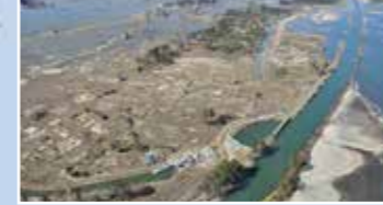
津波被害 (藤塚地区)
