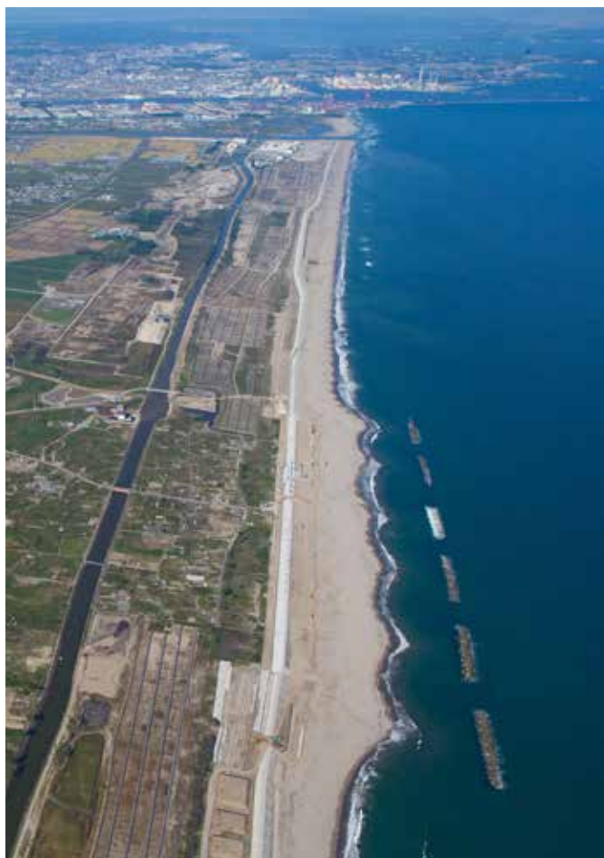
再整備を行った海岸堤防
