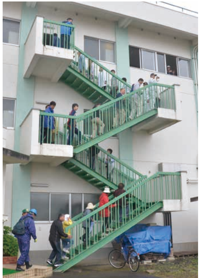
岡田小学校屋上への津波避難訓練
