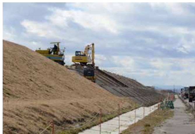
整備が進むかさ上げ道路（平成 28 年 2 月）
