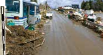
津波被害 (岡田地区)
