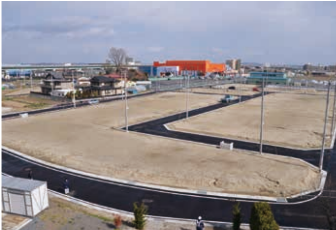
宅地造成が完了した集団移転先（南福室地区）（平成 27 年 3 月）
