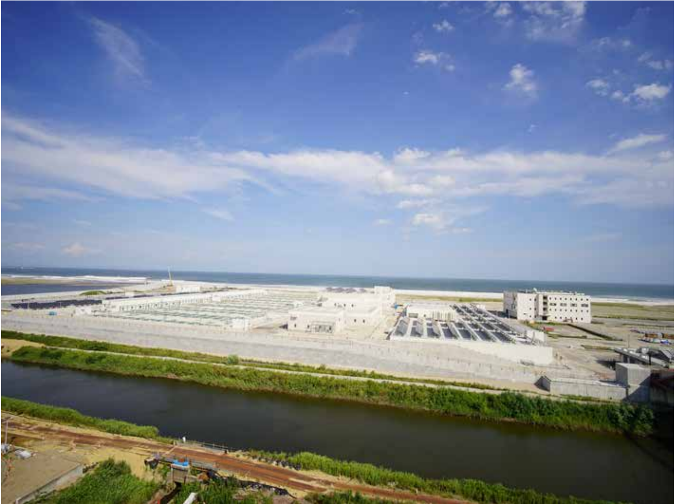
平成 28 年 3 月に復旧工事が完了した南蒲生浄化センター
