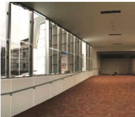
仙台国際センターの窓に貼られたフィルムタイプの有機薄膜太陽電池
