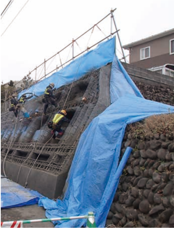
太白区青山二丁目地区の被災宅地復旧工事（平成26年2月）
