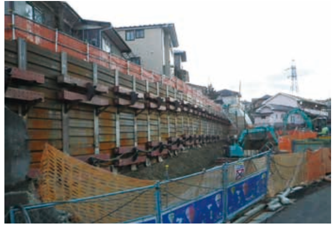
仮設の土留め工事（中山一丁目）（平成27年1月）
