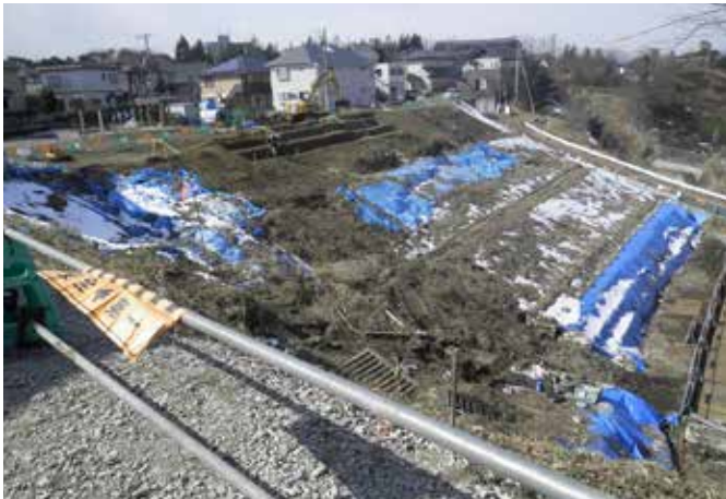
地すべり被害のあった南光台六丁目地区（復旧前）（平成25年2月）
