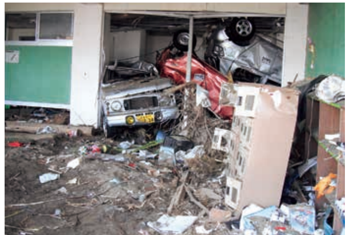
津波の勢いで荒浜小学校1階教室に押し込められた車
