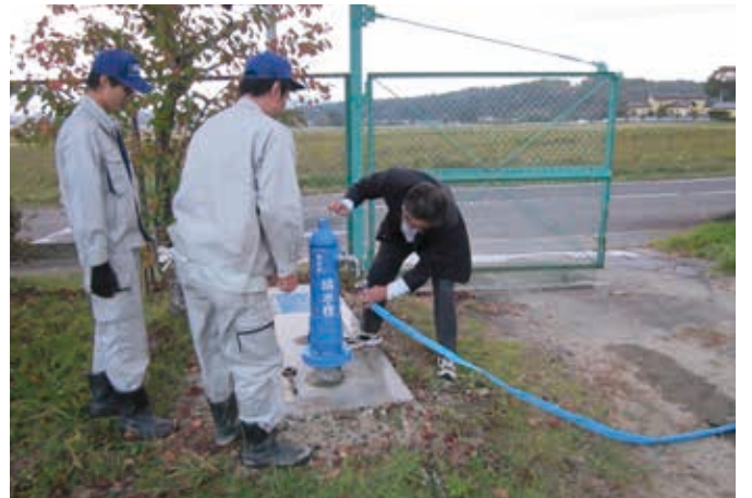
緊急時に備え小学校に設置された給水栓
