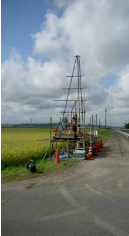
集団移転先宅地造成にあたっての地盤調査 (平成 24 年 9 月)
