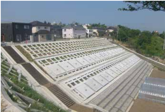
地すべり被害のあった南光台六丁目地区（復旧後）（平成26年8月）
