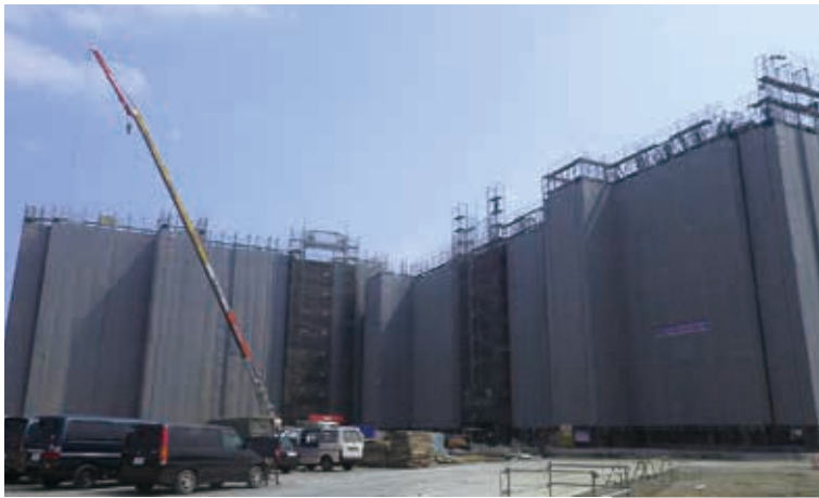
建設が進む荒井東復興公営住宅（平成 25 年 6 月）
