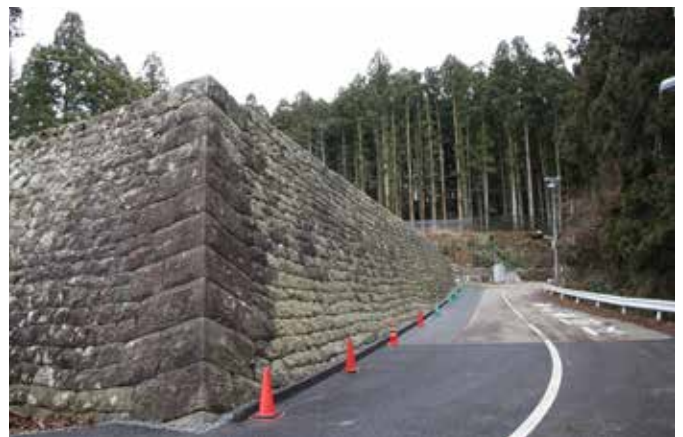
復旧した仙台北城跡石垣（平成27年1月）
