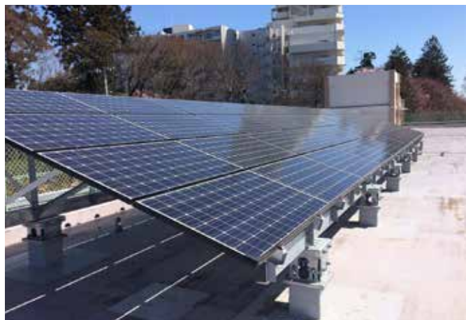
市内194カ所の指定避難所等の屋上に太陽光発電設備を設置
