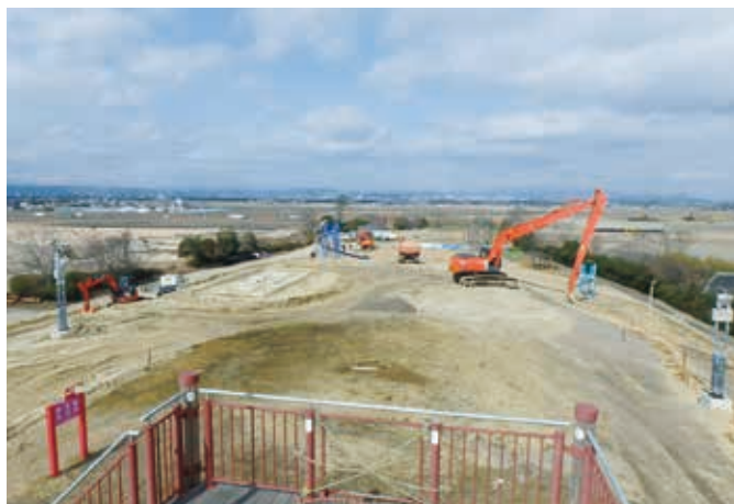
工事の進む海岸公園避難の丘（井土地区冒険広場）（平成 28 年 3 月）
