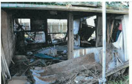
○空き家（東側面）
