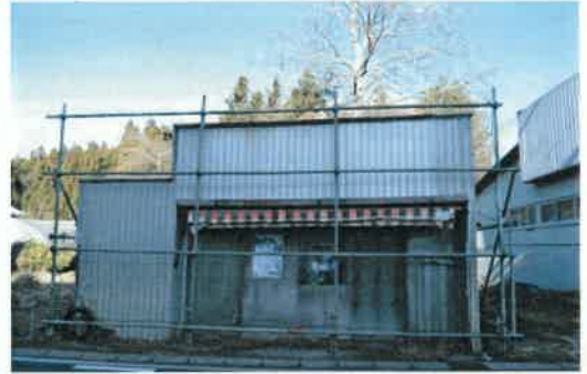
○空き家（国道側：南正面）
