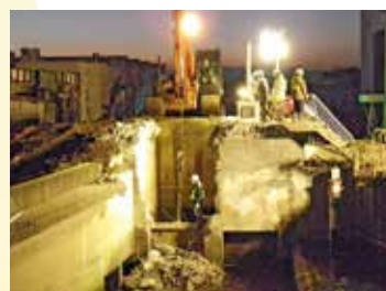
▲発災翌日以降も休むことなく復旧作業に当たりました。写真は放流ゲートのがれき撤去作業
