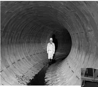
◀全長約6.5キロメートル、直径最大2.8メートルの雨水幹線
