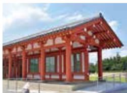
▲陸奥国分寺の廻廊を再現した天平廻廊
