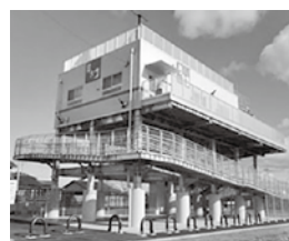
▲若林区の三本塚長屋 敷津波避難タワー
