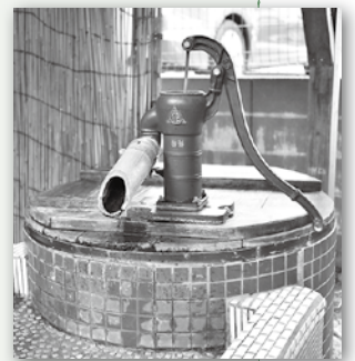
▲井戸の手押しポンプは、平成22年に再整備されたもの
