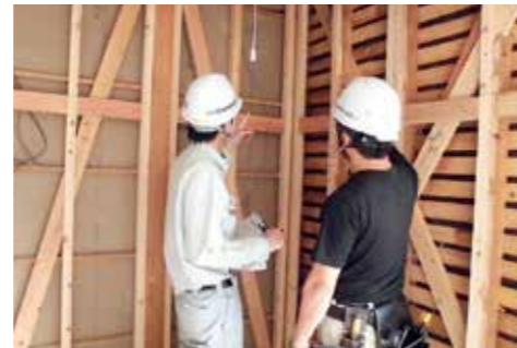
▲耐震改修工事の様子。柱や筋交いの補強状況などをチェックします
