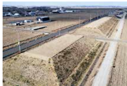
津波からの防御機能を高めるため、東部復興道路のかさ上げ工事を進めています
