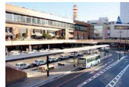
仙台駅西口バスプールの拡張工事等により、東北の玄関口にふさわしい交通結節機能の強化を図ります
