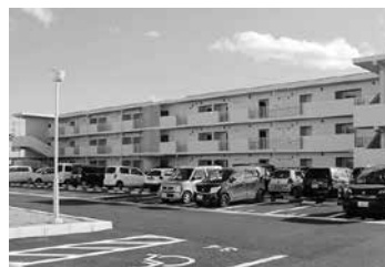
◀荒井南復興公営住宅は、3階建ての2棟に75戸が整備されました
